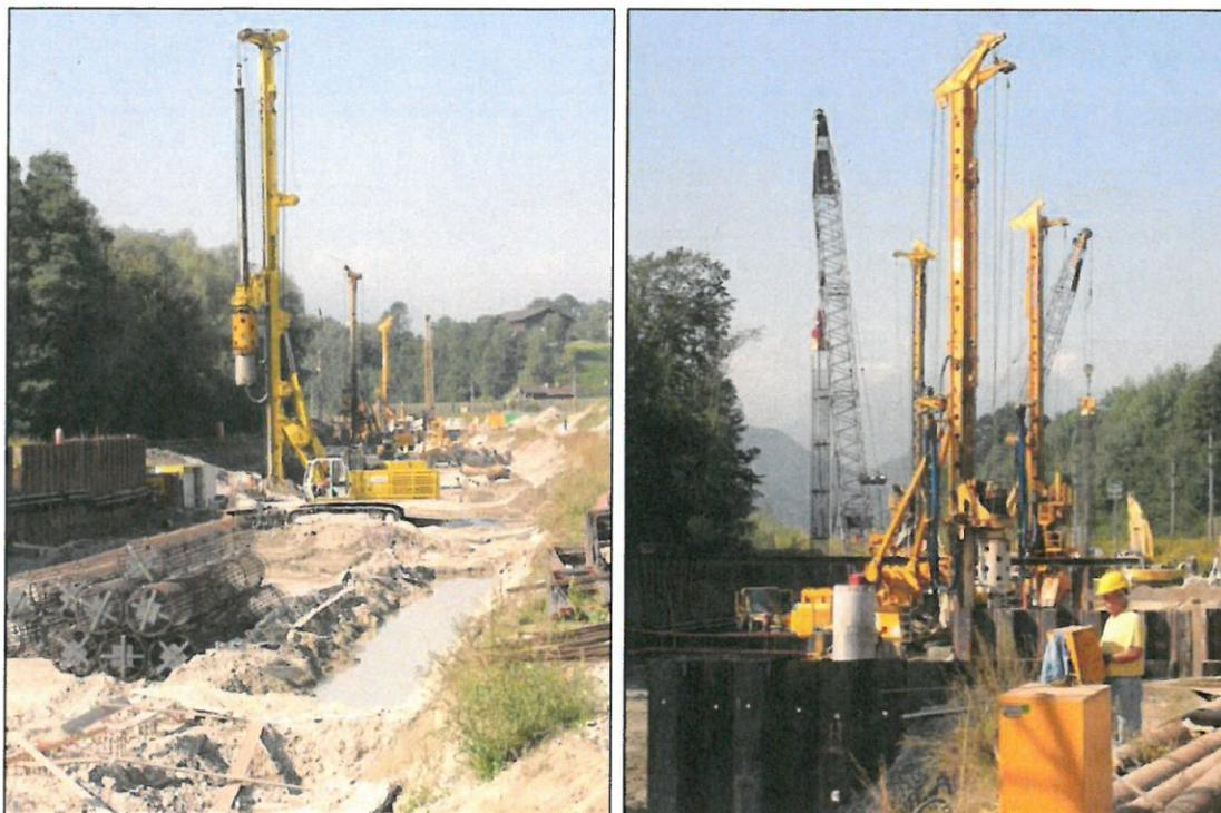
**Abbildung 31:** Sonderbaumaßnahme Deckelbauweise im Bereich Los H7 (Abschnitt Fritzenscher Bogen, Bahnhof Fritzens)
