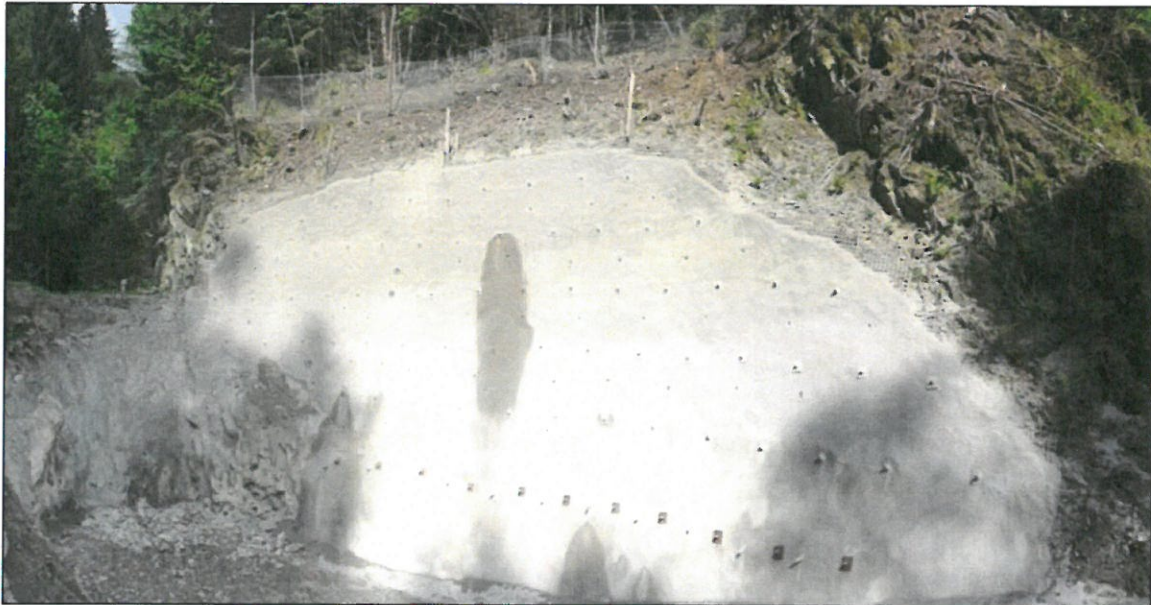
Abbildung 45: Fertiggestellte Baugrube mit geänderter Baugrubensicherung
