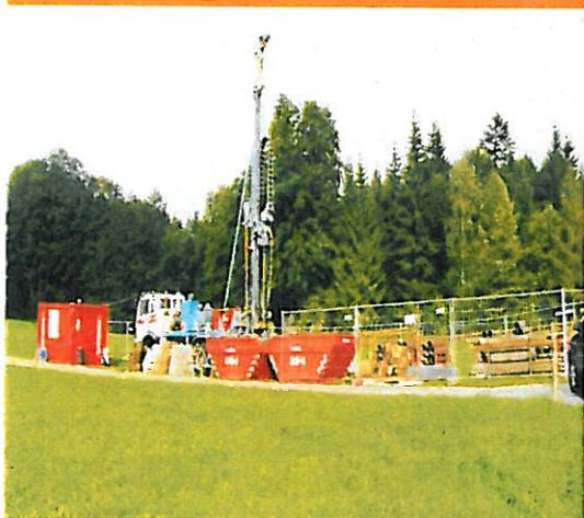
**Bild 4.** Bohranlage einer Gasbohrung mit Spülbecken und Messcontainer.
