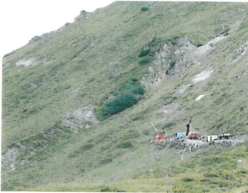
**Bild 9** Erkundung der Stubenbach-Störung mittels Schrägbohrung.
